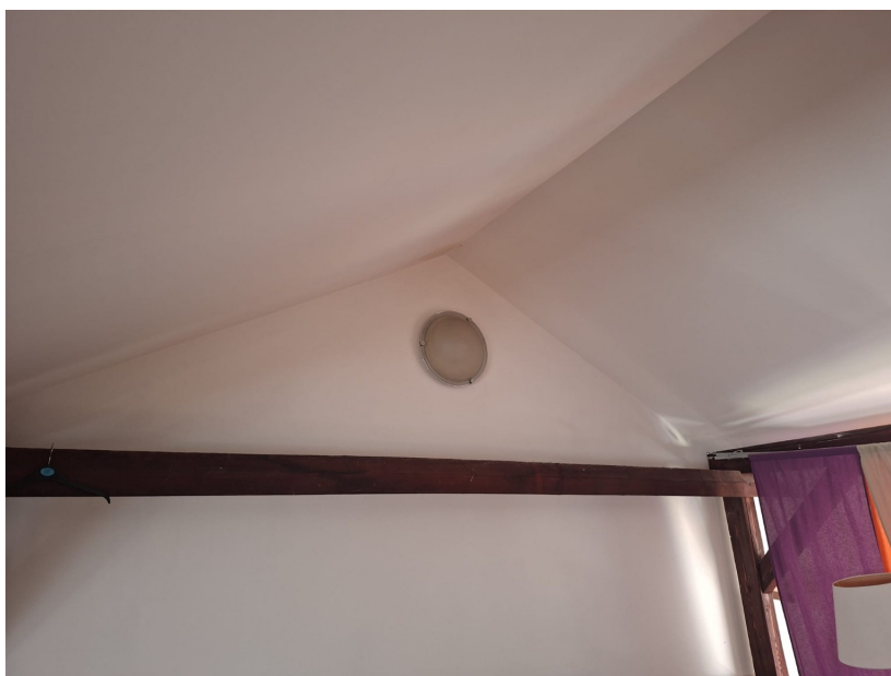
F10 | 33851.jpg — Horní část podkroví: šikmý strop, trojúhelníková stěna, trám a nástěnné svítidlo. Záběr ukazuje více typů návazností na malé ploše. Bez dalších podkladů jej neoznačujeme jako stav před opravou nebo po ní.
