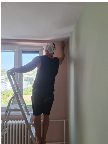
F02 | 33859.jpg — Práce štětcem v horním koutě u stropu a styku barevných stěn. Snímek ukazuje dosahování do detailu; neposkytuje úplný pohled na ustavení žebříku a neslouží jako návod k bezpečnému postoji.
