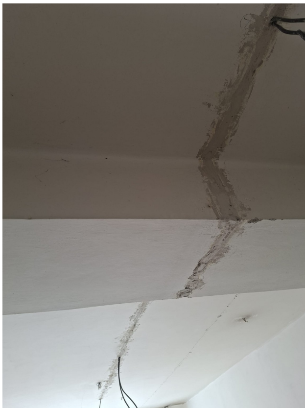
F21 | 33838.jpg — Trasa s hrubě zapraveným povrchem prochází přes strop a vystupující konstrukci. Na několika místech vycházejí kabely. Je patrná nerovnost výplně a jejího napojení na okolí; snímek zachycuje rozpracovaný stav.
