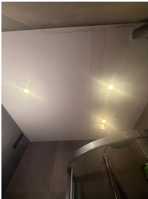
F19 | 33839.jpg — Celkovější záběr koupelnového stropu nad sprchovým koutem. Mapy jsou patrné při okraji stropu i kolem jednoho svítidla. Záběr doplňuje detail F17; časová posloupnost obou snímků není potvrzená.
