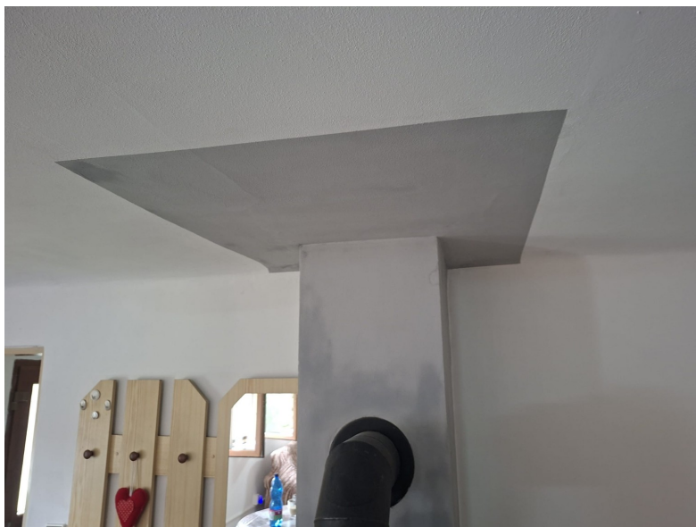
F14 | 33845.jpg — Celkový pohled na ohraničenou šedou plochu stropu nad vystupující částí stěny s kouřovodem. Rozdíl vzhledu vůči okolí je výrazný; účel této úpravy a použitý materiál nejsou doložené.
